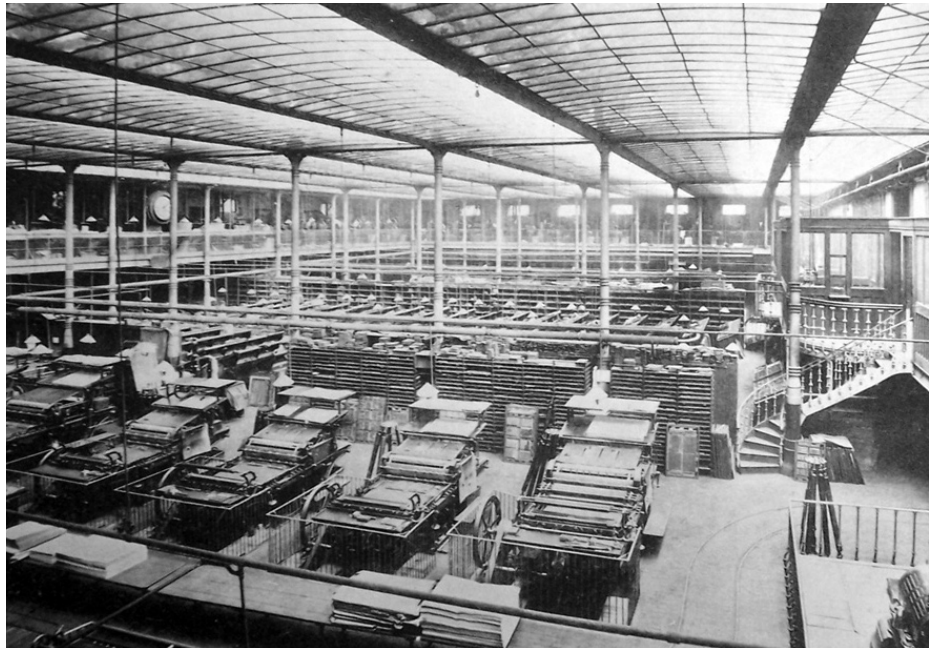
Vue du grand atelier de l'imprimerie Danel, rue Nationale à Lille, en 1875. Doté de machines neuves et performantes, l'atelier était baigné d'une lumière zénithale pratiquement constante, diffusée par le plafond en verre cintré dissimulant les verrières des sheds de couverture. L'édifice a été démoli à une date indéterminée (Source : E. Vandenberg, Métaux , Lille, L. Danel, circa 1905).
